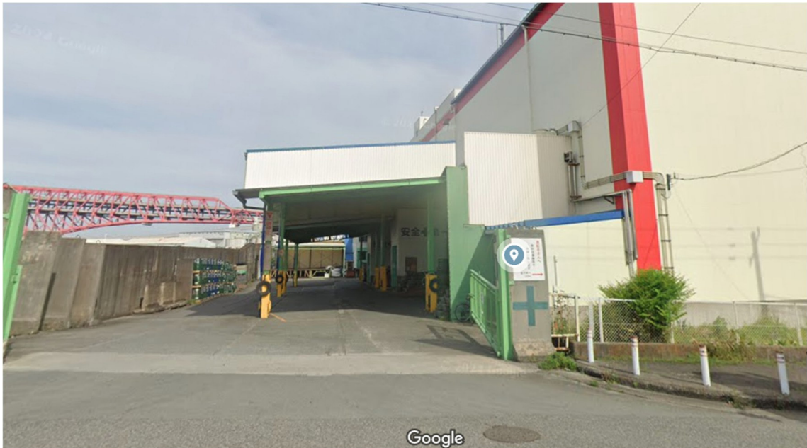
入口写真 (by Google ストリートビュー)
